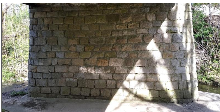
vypadané spárování a kameny zdiva, výkvěty, vápenné výluhy.
